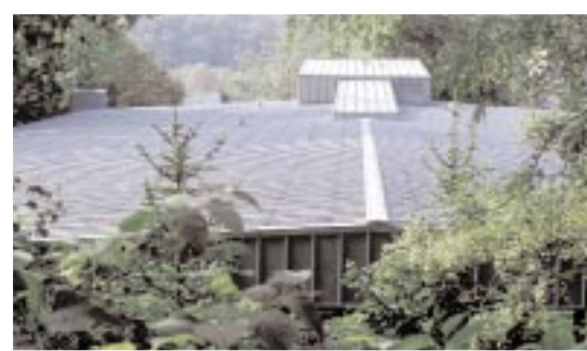
Architectes: CHAMBON - JOASSIN & SIMON
