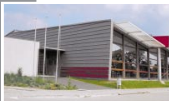
Architectes: CHAMBON - JOASSIN & SIMON
